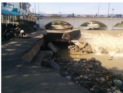
شکل (۲) تخریب خیابان زیرگذر پل چشمه کیله واقع در مرکز شهر تنکابن (مهر ۱۳۹۷)
