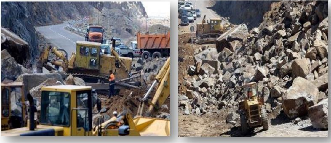
شکل ۲: پاک سازی جاده زنجان - تهم - طارم و رفع انسداد ناشی از سنگ ریزش مواد و روش ها
