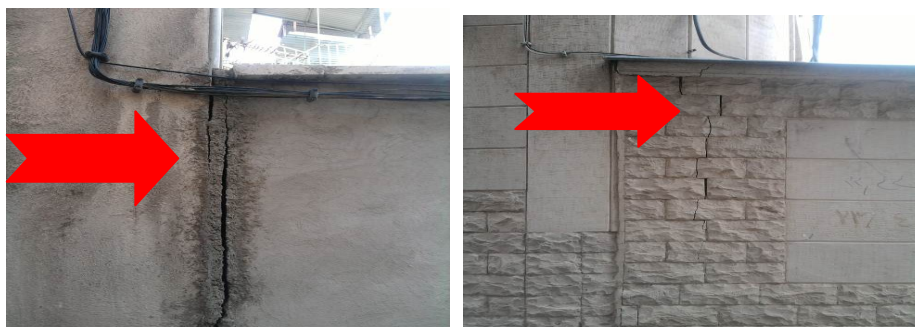
شکل (۲ و ۳) درز و شکاف ایجاد شده بر روی دیوار منازل نو ساز و قدیمی
