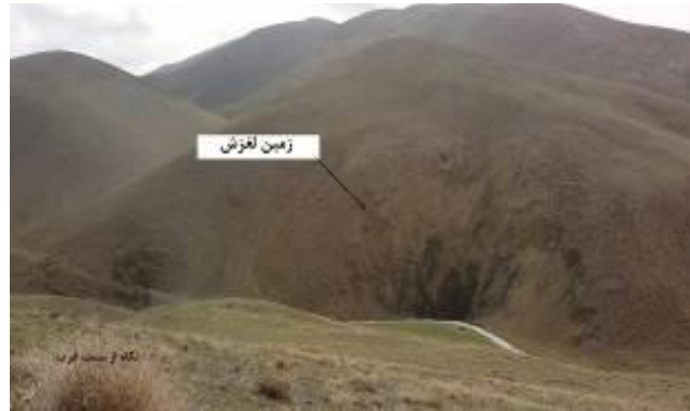
شکل (۴). زمین‌لغزش در سنگ آهکی KI2 در قسمت جنوبی حوضه کرفس، این پدیده به دلیل افزایش ارتفاع دامنه در اثر فعالیت تکتونیکی، شیب افزایش یافته و پای دامنه نیز توسط رودخانه خالی شده که این عمل باعث ریزش دامنه شده است (موقعیت در شکل ۱). (فروردین ۹۹)
