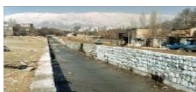
شکل (۲). تصاویر وضع موجود رودره درکه
