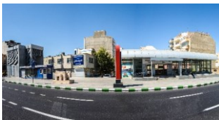
شکل (۸). ناهماهنگی بدنه ایستگاه مترو
