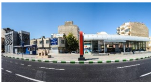
شکل (۸). ناهماهنگی بدنه ایستگاه مترو
