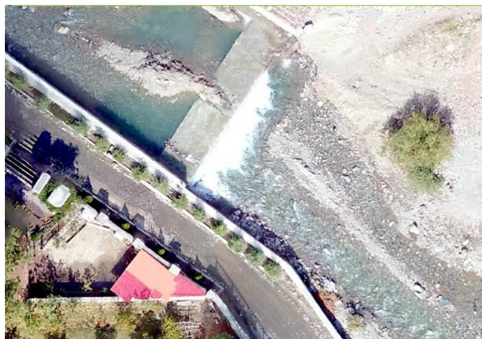
شکل (۱۰). ایجاد بستر مصنوعی و پیدایش تندآب و همچنین وجود موانع طولی متعدد در درون کانال در بازه ۴
