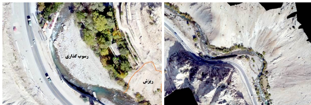
شکل (۱۲). وجود دامنه‌های ناپایدار در حاشیه رودخانه در بازه ۵
