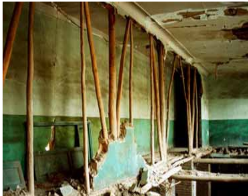
شکل (۸). بادبند مورب در صفحه عمودی - هر چه به سمت فوقانی بنا پیش می‌رویم از مصالح سبک‌تری همچون چوب استفاده می‌شود و در دیوار پایینی از طاق و جرز آجری استفاده شده است.
