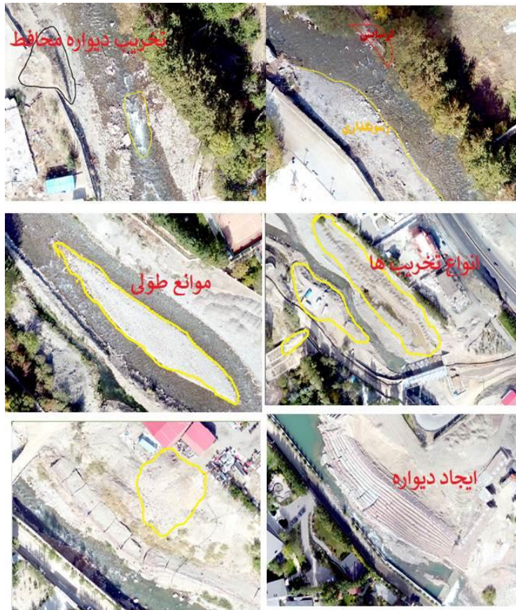
شکل (۱۱). رسوب گذاری و فرسایش در بازه ۴
