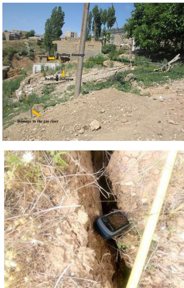
شکل ۱۱. تصاویری از ایجاد شکاف کششی در تاج شیب و آسیب ناشی از آن به سازه‌ها در پروفیل B Fig. 11. Images of tensile crack formation at the slope crest and the resulting damage to structures in Profile B
