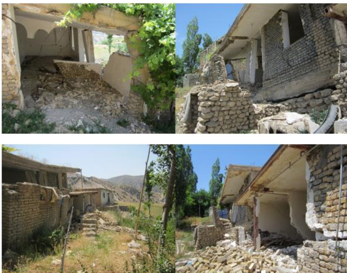
شکل ۱. ترک‌های ایجاد شده و تخریب منازل مسکونی روستای تلوبین ناشی از رخداد زمین‌لغزش
