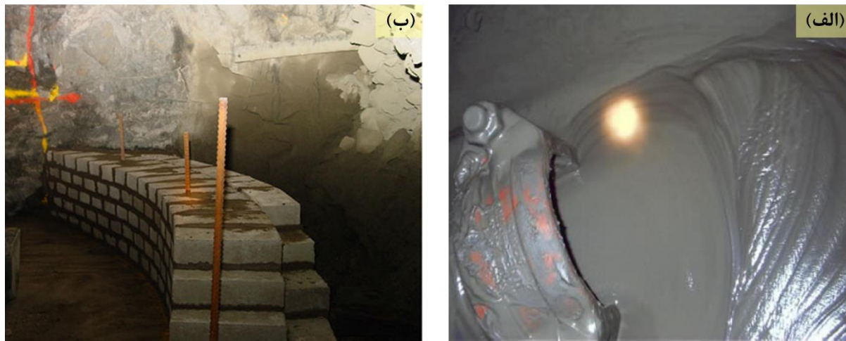
شکل ۱. الف) نمونه‌ای از بافت پرکننده هیدرولیکی (Ibishi, 2019) ب) دیوار ساخته شده از آجرهای متخلخل (Sivakugan et al., 2013)
