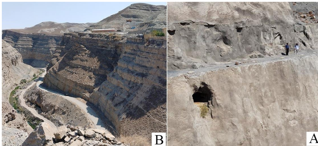
شکل ۹. A) حفره (غارچه) انحلالی آهک‌های سازند تیرگان در امتداد شکستگی‌ها در جناح چپ سد (دید به شمال)، و B) دره کارستی پایین دست سد (دید به شرق).
