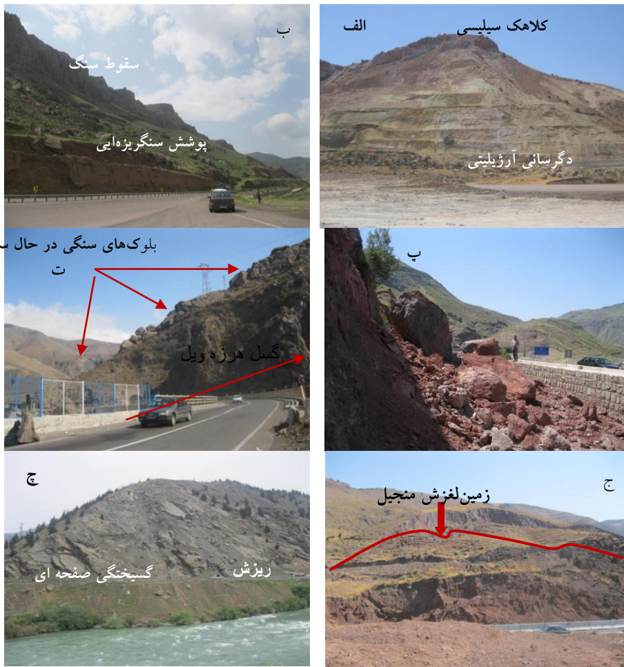
شکل ۴. نمایی از زمین لغزش‌های رخ داده در مسیر آزادراه قزوین - رشت، الف) سقوط بلوک‌های سنگی در قسمت بالای ترانشه و زمین لغزش در سری سنگ‌های آندزیت با آلتراسیون شدید (ایستگاه اول: کیلومتر ۷۰۰+۴۲). ب) سقوط و ریزش بلوک‌های سنگی در سری سنگ‌های آندزیتی و پوشش سنگریزه‌ایی در قسمت پایین ترانشه (ایستگاه ۹: کیلومتر ۶۰۰+۵۲، عکس به-سمت جنوب شرق گرفته شده است. پ) ریزش بلوک‌های سنگی در سری سنگ‌های آندزیتی و نهشته‌های آذرآواری (ایستگاه ۱۰: کیلومتر ۹۰۰+۵۷). ت) سقوط و ریزش بلوک‌های سنگی در سری سنگ‌های آگلومرای خاکستری (ایستگاه ۱۵: کیلومتر ۱۴۰). ج) زمین لغزش منجیل که در تاریخ ۹۲/۴/۴ اتفاق افتاد و از کیلومتر ۸۰۰-۱۰۲+۵۰۰ آزادراه را مسدود کرد. عکس روبه جنوب گرفته شده است. چ) گسیختگی صفحه‌ای به موازات شیب توپوگرافی و ریزش در سری کنگلومراهای هوازده سازند شمشک در ناحیه خلیل آباد رودبار (ایستگاه ۲۱: کیلومتر ۱۰۵).
