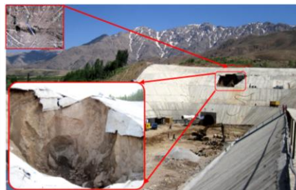
شکل ۲. تصویری از دهانه تونل سبزکوه و حفره ریزشی
