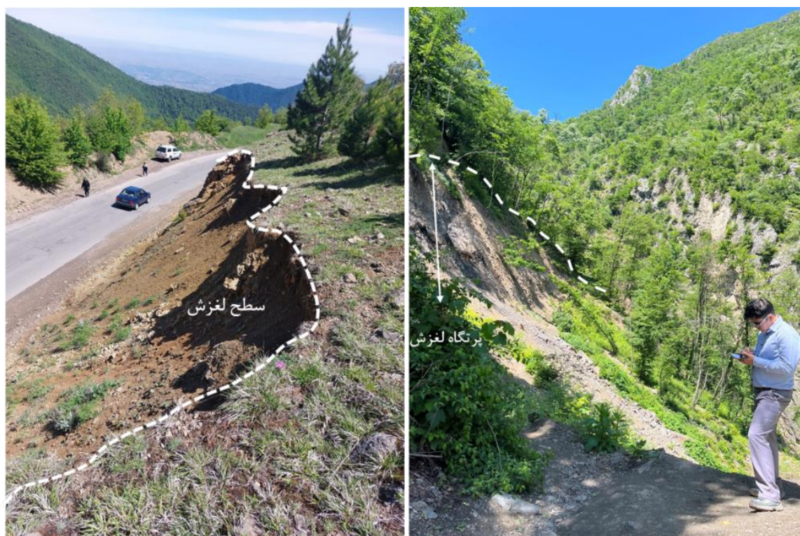
شکل ۱. تصاویری از برخی لغزش‌های رخ داده در مجاورت جاده توسکستان Fig. 1. Photographs of landslides that occurred in the vicinity of Tuskestan road
