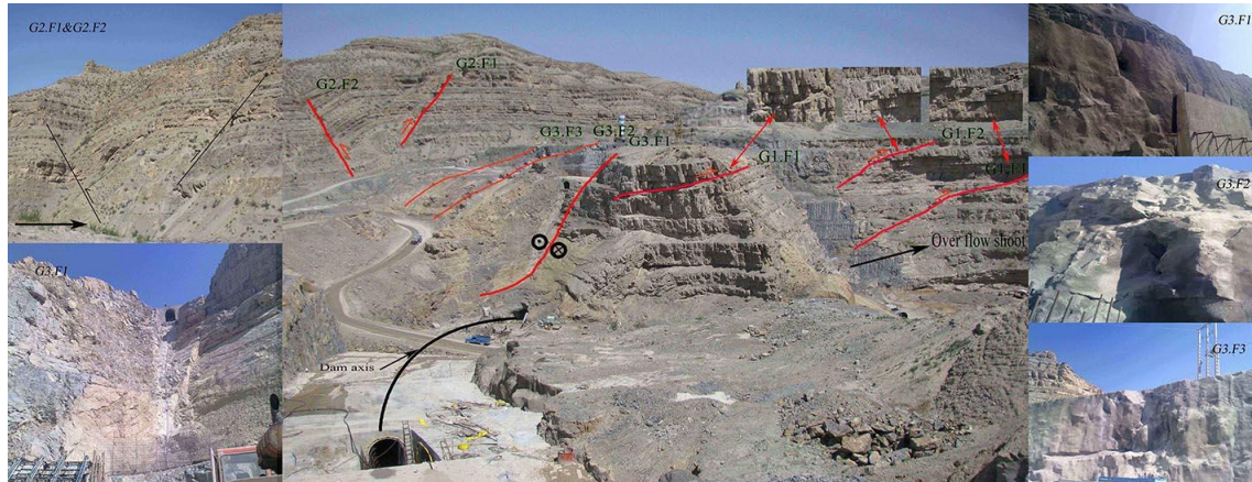
شکل ۴. عملکرد سه سامانه گسلی در جناح چپ سد قره‌تیکان.
