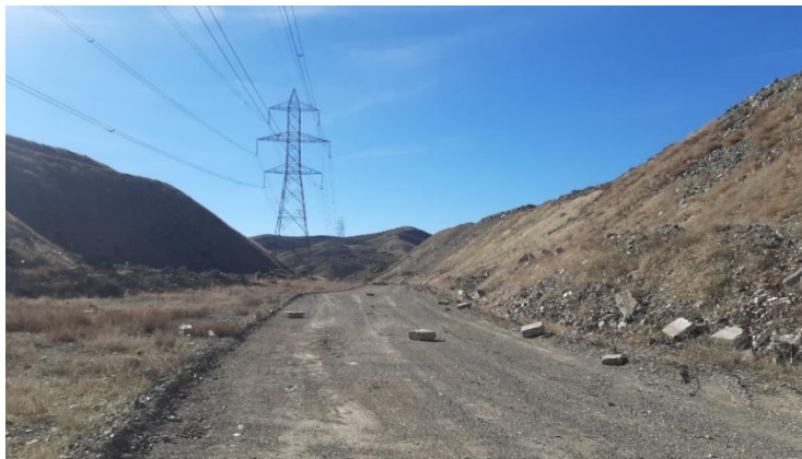
شکل ۱- محل دپوی پسماندهای ساختمانی منطقه مورد مطالعه در پژوهش حاضر
