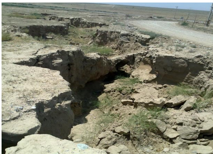
شکل ۱. تهدید و تخریب راه‌ها در اثر فرسایش لس‌های شهرستان کلاله، استان گلستان
