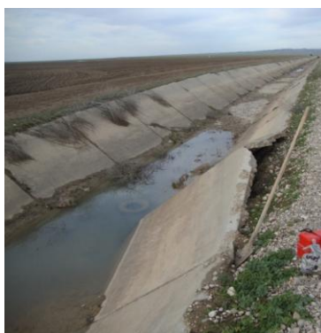
شکل ۱. نمایی از محدوده آزمایش خاک واقع در کانال‌های اصلی شبکه سد بوستان گنبد و خرابی‌های رخ داده شده در آن
