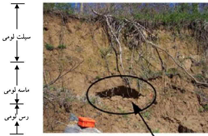
فرسایش ناشی از تراوش
